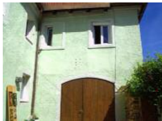
Innenhof, in der Putzstruktur erkennbar die alte Fenstergröße
