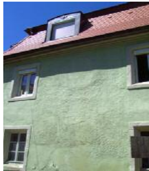
Sicht vom Landauergarten aus, im Putz ist der ehemalige Platz des Toraschreins und des ehemaligen Rundfensters darüber erkennbar
